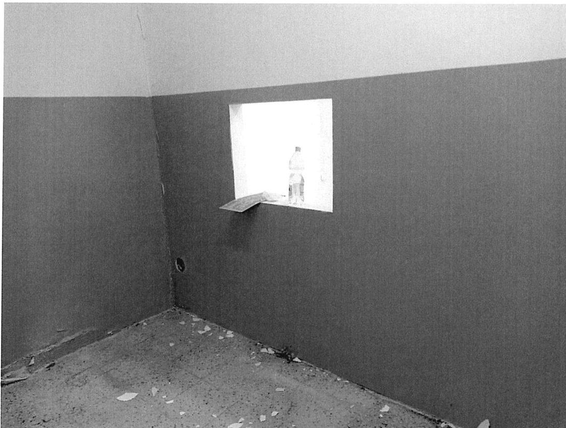
Zdjęcie nr 21 – widok pomieszczenia zaplecza. Zaplanowano naprawę tynków, malowanie ścian i sufitów farbą akrylową paroprzepuszczalną, zmywalną i szorowalną oraz lamperii farbą ftalową (alkidową).
