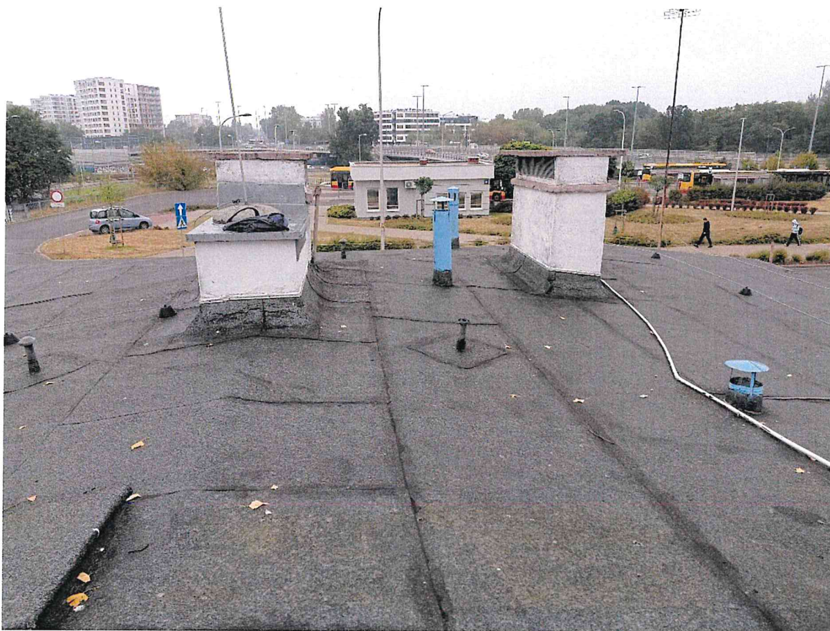
Zdjęcie nr 5 - widok dachu, kominy i pokrycie dachowe przeznaczone do remontu.
