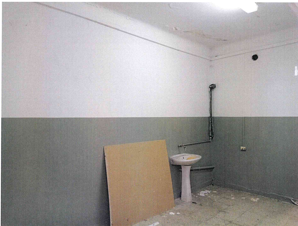
Zdjęcie nr 26 – pomieszczenie zaplecza przeznaczone do prac remontowych. Miejskie Zakłady Autobusowe Sp. z o.o., 01-710 Warszawa, ul. Włociańska 52
