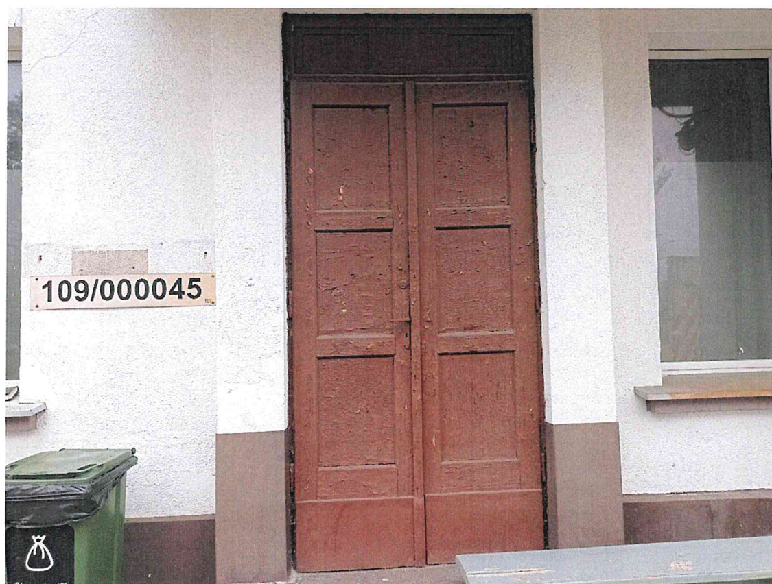
Zdjęcie nr 28 – elewacja wschodnia, drzwi drewniane pozostają do konserwacji, przeznaczone do malowania farbą ftalową (alkidową).
