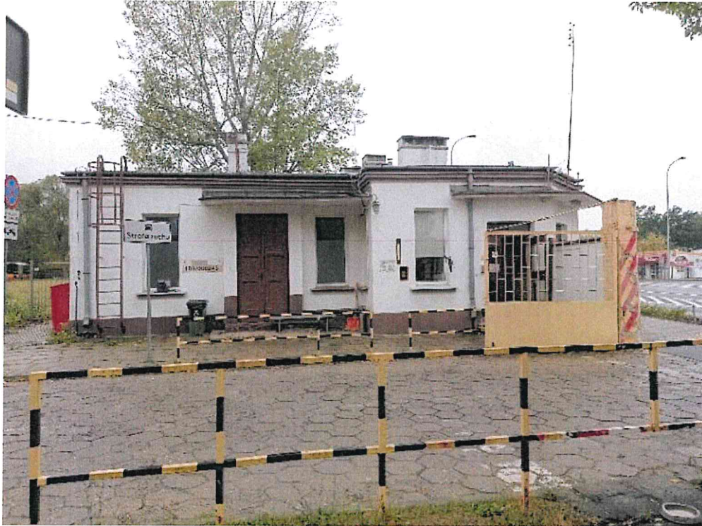
Zdjęcie nr 1 – ogólny widok portierni. Widok elewacji wschodniej.
