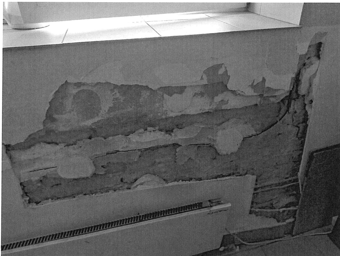
Zdjęcie nr 15 – widok odkrywki ściany murowanej po zdjęciu zabudowy z płyt g-k.
