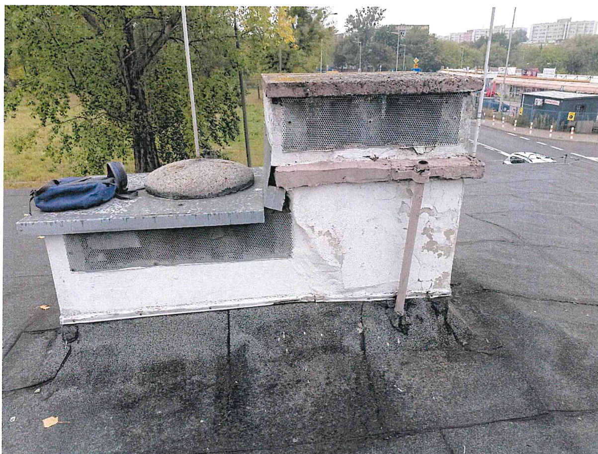
Zdjęcie nr 6 - widok dachu, kominy i pokrycie dachowe przeznaczone do remontu
