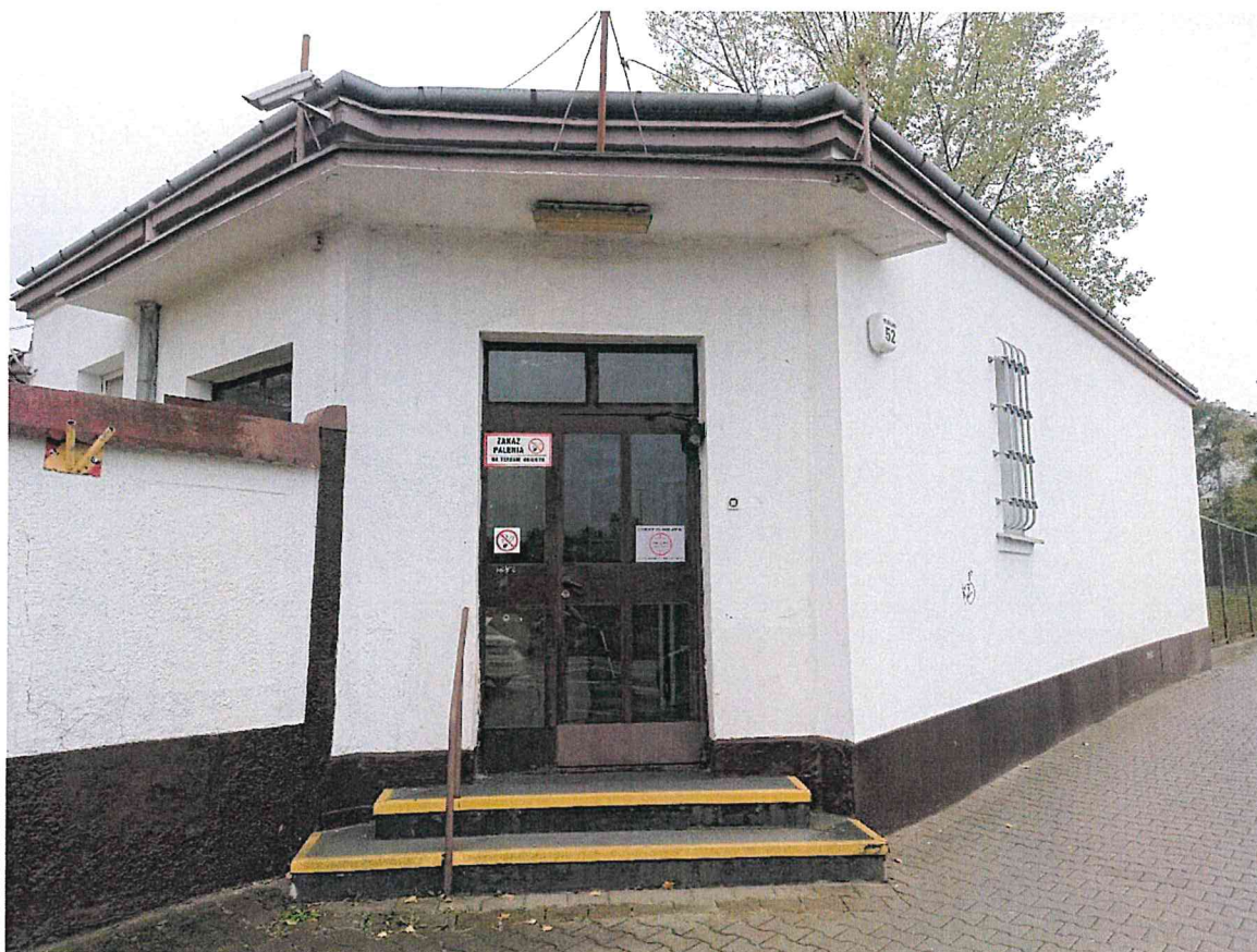
Zdjęcie nr 14 – stalowe drzwi na wprost przeznaczone do malowania, na lewo murek ceglany do remontu z obróbką, widok elewacji północnej (ocieplona ściana na prawo) – zaplanowano otynkowanie ściany elewacji północnej tynkiem silikonowym.
