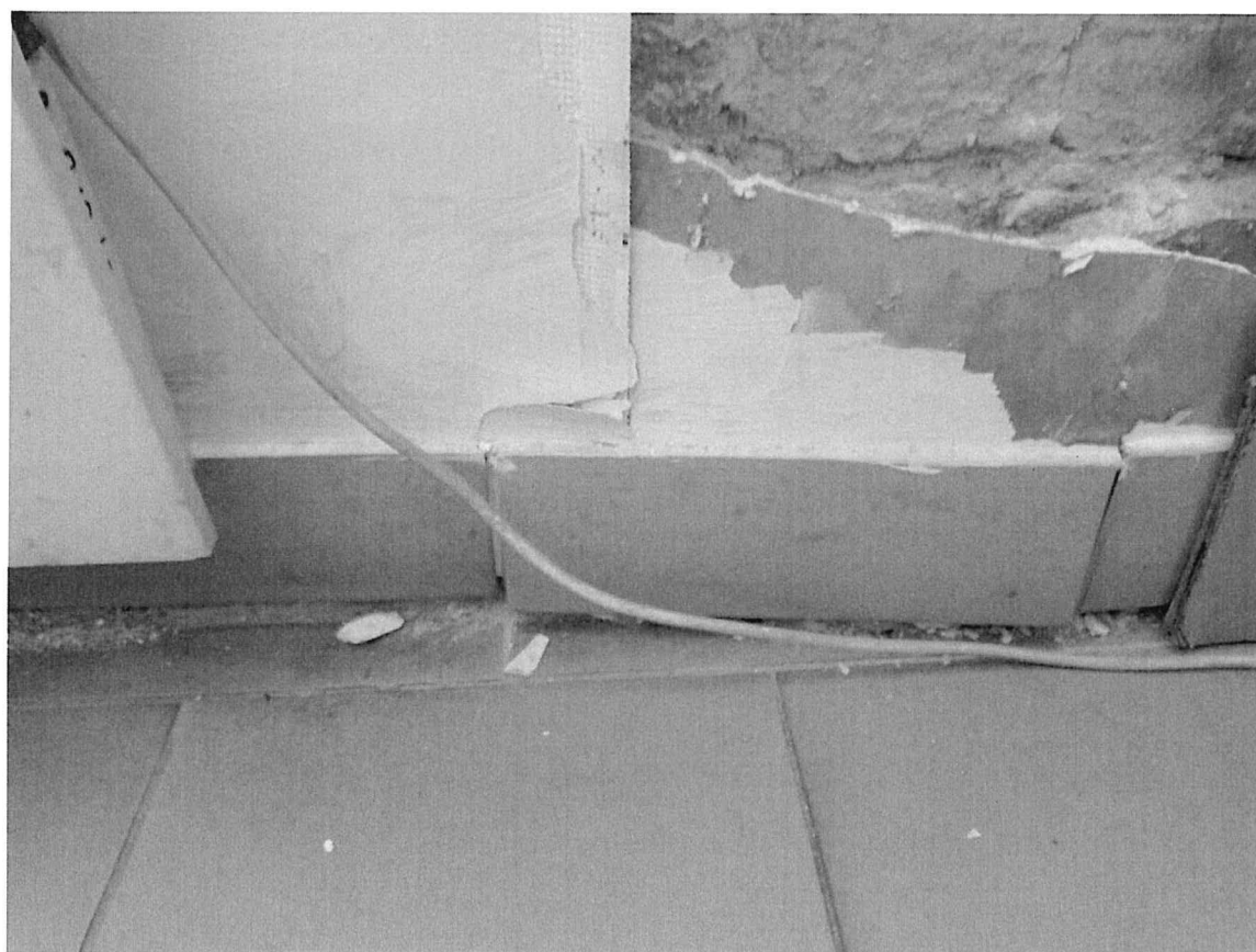
Zdjęcie nr 16 – widok odkrywki ściany murowanej po zdjęciu zabudowy z płyt g-k.
