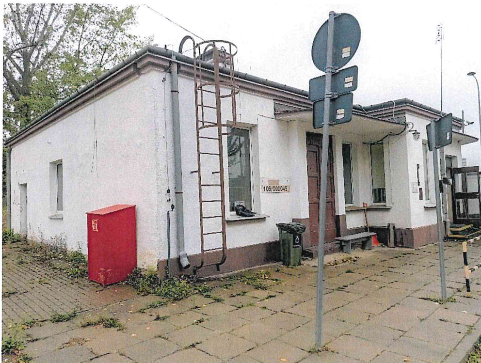
Zdjęcie nr 2 – elewacja wschodnia (od frontu) oraz elewacja południowa (ściana na lewo). Miejskie Zakłady Autobusowe Sp. z o.o., 01-710 Warszawa, ul. Włociańska 52
