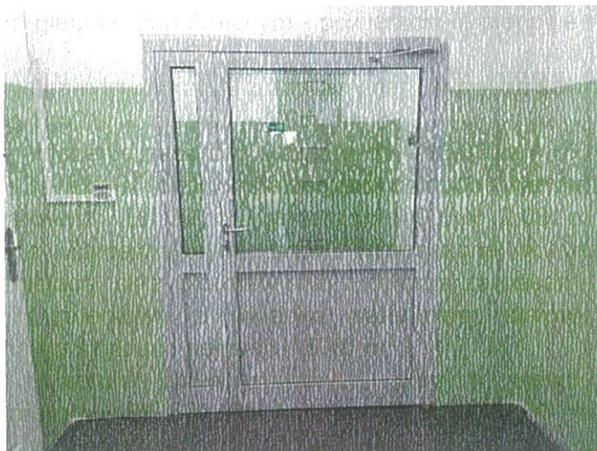
Zdjęcie nr 1 – drzwi dwuskrzydłowe z PVC do wykucia z muru na poziomie II piętra, Zamawiający zaplanował montaż drzwi stalowych EI 60 o wymiarach 0,90 x 2,00 m.
