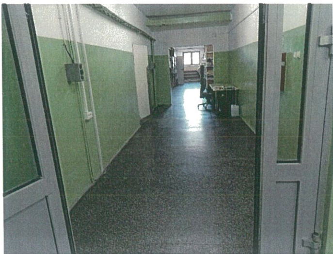
Zdjęcie nr 6 - korytarz na poziomie II piętra przeznaczony do malowania i wymiany stolarki drzwiowej drewnianej na drzwi stalowe EI 30 o wymiarach 0,90 x 2,00 m.
