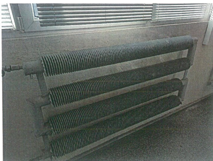
Zdjęcie nr 15 – Zamawiający zaplanował dwukrotne malowanie farbą olejną grzejników rurowo-żebrowych oraz dwukrotne malowanie lamperii z dwukrotnym szpachlowaniem.
