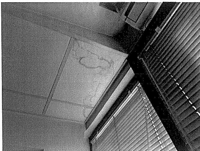
Zdjęcie nr 9 – uszkodzone panele sufitu podwieszanego w pomieszczeniu na I piętrze przeznaczone do wymiany na nowe.
