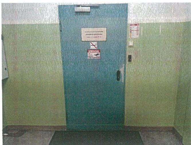
Zdjęcie nr 2 – zaplanowano obustronne malowanie stalowych drzwi wejściowych na poziomie I piętra. Posadzka z płytek z tworzywa sztucznego do zerwania, zaplanowano ułożenie okładziny podłogowej z płytek gresu nieszkliwionego.
