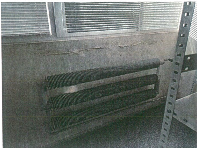
Zdjęcie nr 3 – Zamawiający zaplanował dwukrotne malowanie farbą olejną grzejników rurowo-żebrowych oraz dwukrotne malowanie lamperii z dwukrotnym szpachlowaniem.
