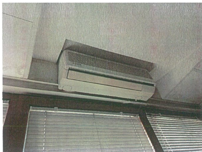
Zdjęcie nr 11 – uszkodzony klimatyzator w pomieszczeniu na I piętrze. Należy zlikwidować wyciek czynnika chłodniczego z klimatyzatora na nadproże okienne do środka pomieszczenia. Instalacja odpływu wyprowadzona na zewnątrz, na elewację budynku.
