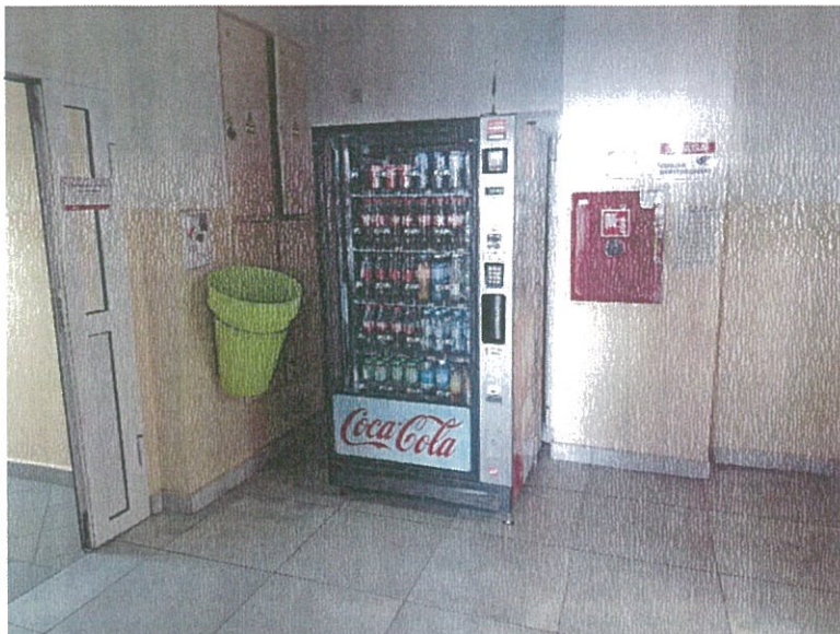
Zdjęcie nr 7 - szafka hydrantowa z zaworem Dn 52 w zabudowie w przedsionku klatki schodowej przeznaczona do wymiany na nową łącznie z nową zabudową gips-karton.
