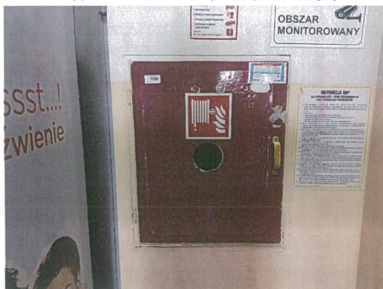
Zdjęcie nr 8 - szafka hydrantowa z zaworem Dn 52 w zabudowie w przedsionku klatki schodowej przeznaczona do wymiany na nową łącznie z nową zabudową gips-karton.
