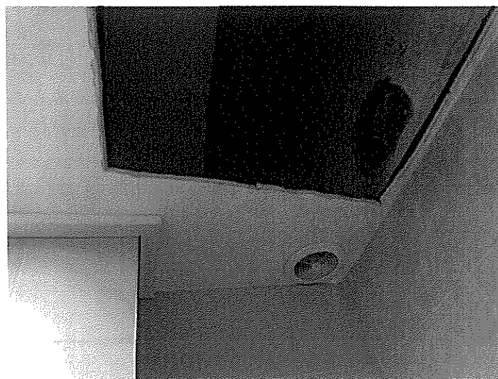
Zdjęcie nr 11 - sufit podwieszany z płyty gips-karton w łazience przeznaczony do demontażu.
