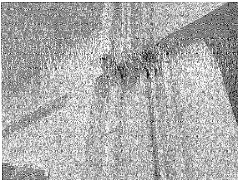
Zdjęcie nr 16 – nieszczelne połączenie rur kanalizacyjnych w strefie kolanka wymaga naprawy.
