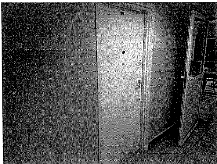
Zdjęcie nr 3 - należy zamontować do pomieszczenia technicznego nowe drzwi wzmocnione klasy RC3.
