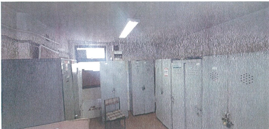
Zdjęcie nr 4 – widok pomieszczenia szatni. Zaplanowano ułożenie nowej okładziny podłogowej z płytek gresu oraz malowanie pomieszczenia razem z rurami stalowymi i grzejnikami rurowo-żebrowymi.
