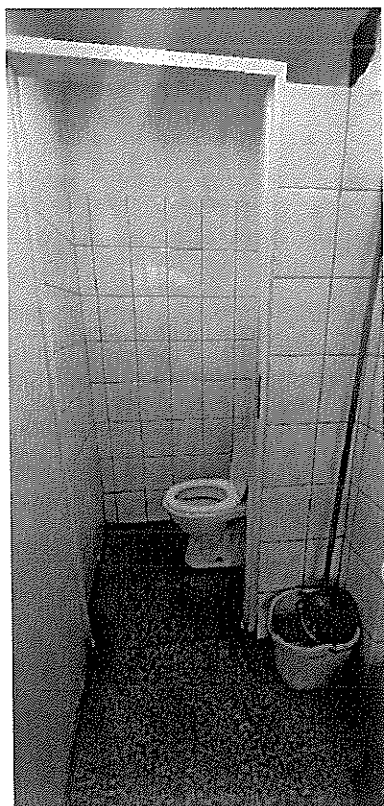
Zdjęcie nr 3 — widok pomieszczenia sanitariatu. Zaplanowano ułożenie nowej okładziny podłogowej i ściennej z płytek gresu, rozbiórkę istniejącej ścianki, montaż nowej ścianki z HPL, malowanie pomieszczenia. Ponadto należy zdemontować istniejącą miskę ustępową ze spluczką, zamontować nową miskę ustępową typu Geberit.
