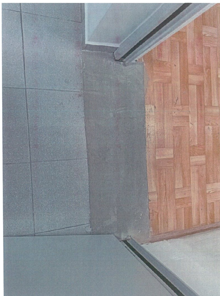
Zdjęcie nr 5 - widoczny brak wykończenia posadzki w klatce schodowej w Budynku Socjalnym. Należy wykuć istniejące podłoże betonowe i ułożyć brakującą okładzinę podłogową z płytek gresu.
