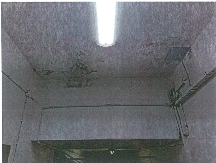
Zdjęcie nr 6 - widoczny brak wykończenia przejścia poziomego c.o. przez przegrodę pionową w klatce schodowej w Budynku Socjalnym. Należy zamontować brakującą osłonę (gilzę) z naprawą tynku.
