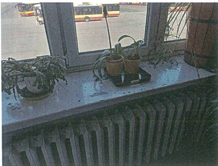
Zdjęcie nr 13 - parapet na klatce schodowej w Budynku Administracyjnym. Zamawiający zaplanował roboty naprawcze z końcowym malowaniem oraz pokrycie parapetu gęstą osłoną, np. z blachy stalowej powlekanej w kolorze białym.
