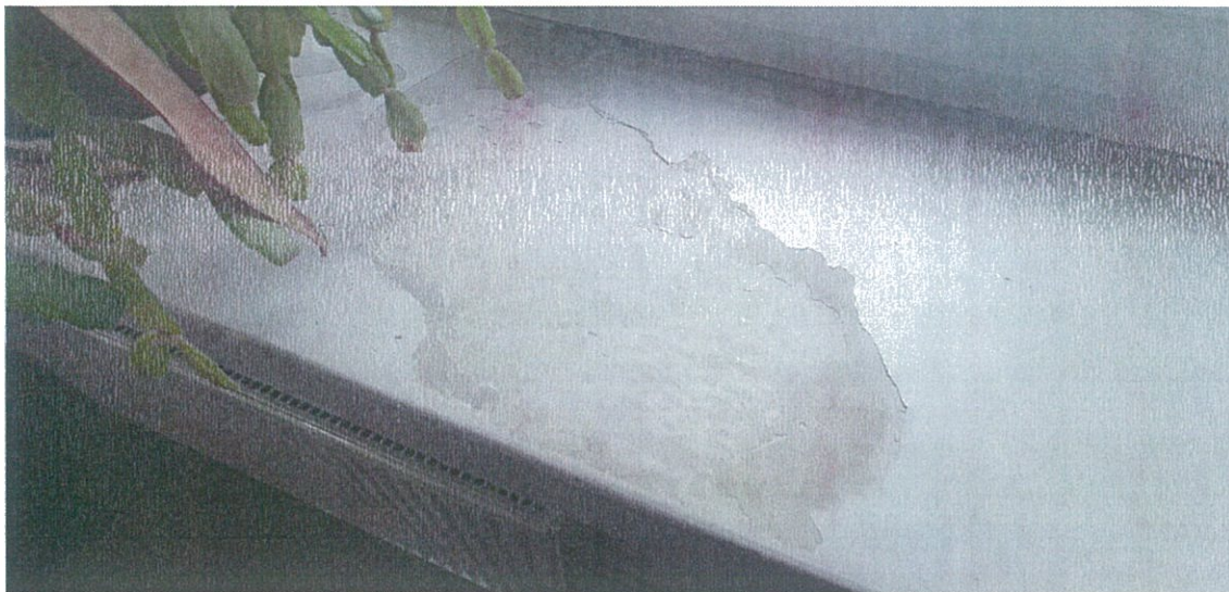
Zdjęcie nr 6 – pomieszczenie kadr. Złuszczona farba na powierzchni parapetów. Parapety okienne przeznaczone do malowania z uprzednim przygotowaniem powierzchni.
