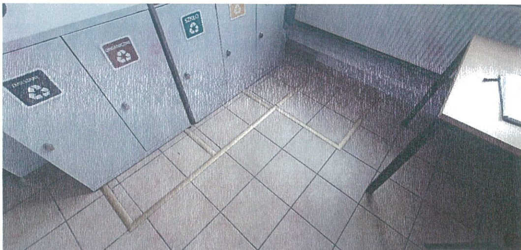
Zdjęcie nr 3 – posadzka z płytek ceramicznych do wymiany na nową w pomieszczeniu przed Salą Konferencyjną.
