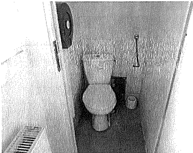
Zdjęcie nr 7 – kabina z miską ustępową w sanitariacie męskim na I piętrze do rozbiórki. Zaplanowano nową zabudowę ścianek i drzwi z płyt HPL, montaż nowej miski ustępowej oraz umywalki szafkowej z podłączeniem do instalacji c.w. i z.w.
