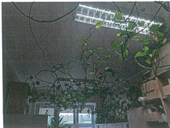
Zdjęcie nr 1 – ogólny widok dyspozytorni od strony holu wejściowego w budynku administracyjnym. Prawe okienko podawcze przeznaczone do likwidacji i zabudowy płytami gips-karton. Pozostałe dwa okna do likwidacji i zamontowania dwóch nowych okien z PVC, razem z parapetami z konglomeratu grubości 3 cm. Nad oknami należy zamontować dodatkową instalację oświetleniową.
